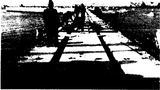
Foto 39 y 40: Vaciado, vibrado y nivelación de concreto en juntas. MUELLE.
