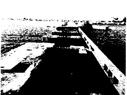
Foto 43 y 44: Demolición de losas y viga cabezal para reparación en puente. MUELLE.
