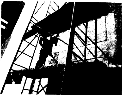
Foto 17 y 18: Pintado de muros con imprimante. EXTERIOR ZONA DE SERVICIOS.
