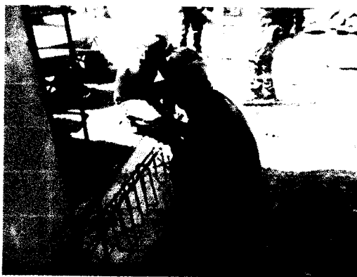
Foto 11 Y 12: Colocación de acero para sobrecimiento. PTAR.
