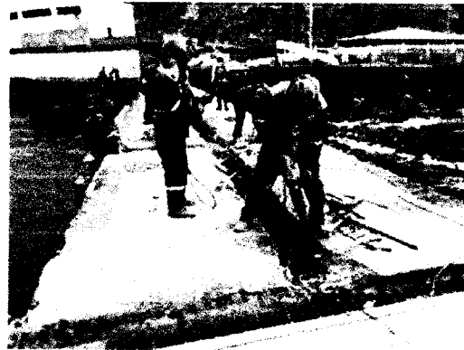
Foto 47 y 48: Demolición de losas en puente. MUELLE.
