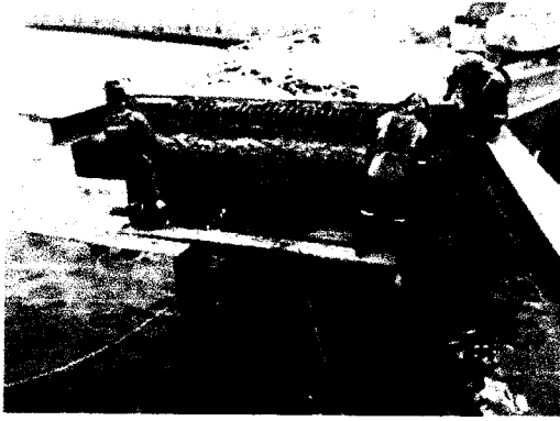
Foto 45 y 46: Demolición de losas y viga cabezal para reparación en puente. MUELLE.
