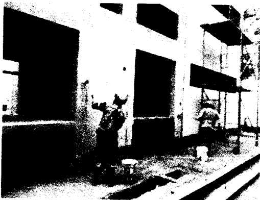
Foto 19 y 20: Pintado de muros exteriores con imprimante. ZONA RECEPCIÓN DE ALIMENTOS/ CUARTO DE BOMBA
