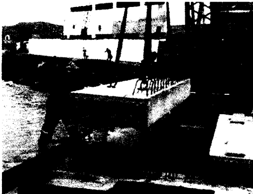
Foto 33 y 34: Transporte y colocación de losas y acero en juntas. Puente de acceso
