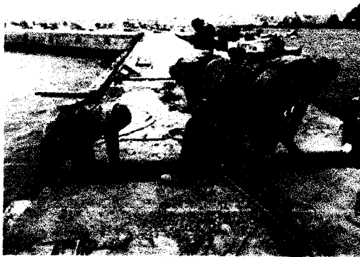
Foto 47 y 48: Demolición de losas en puente. MUELLE.
