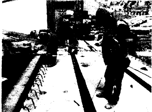
Foto 41 y 42: Encofrado de fondo en juntas longitudinales. MUELLE.
