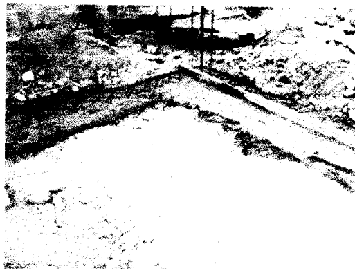
Foto 09 Y 10: Vaciado de concreto para cimientos corridos. PTAR.
