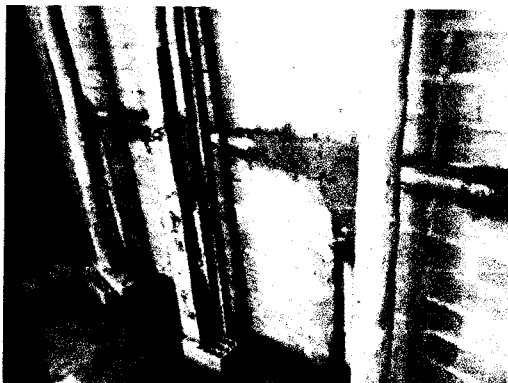
Foto 29 y 30: Instalación de tuberías de 2" para desagüe. Zona de servicios 2do Piso
